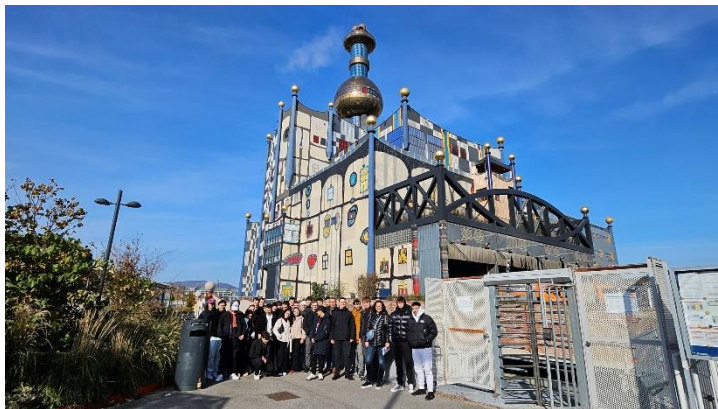
Exkursion nach Wien: Dazu gehörte der Besuch einer Müllverbrennungsanlage in Spittelau. Ihre Besonderheit liegt in der von Friedensreich Hundertwasser künstlerisch gestalteten Fassade. Fotos: HS Esslingen
